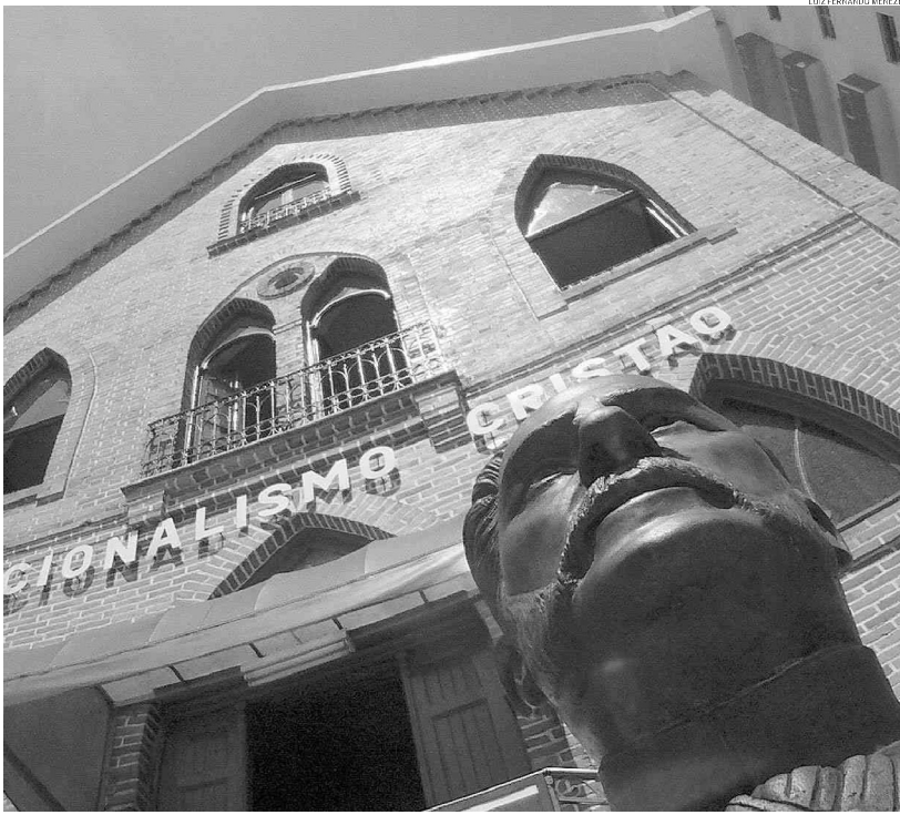
Inaugurado em 1912, o vistoso prédio na Avenida Ana Costa, em Santos, é único do litoral paulista com arquitetura baseada no Gótico Vermelho
